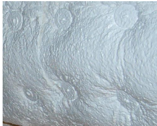
高温炉锚固钉保护
